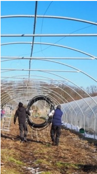
Februar 2025: Abbau Folientunnel Blumberg
